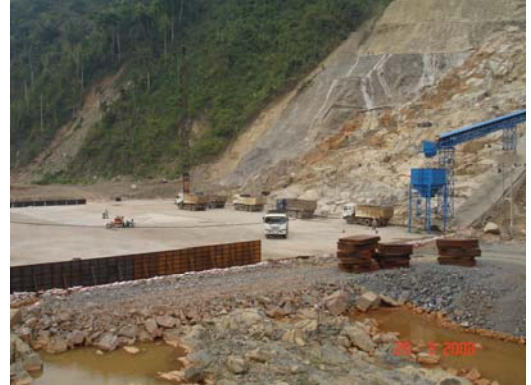
Thủy điện Đồng Nai 3, H=108m. Một trong 5 Đập RCC cao trên 100m của Việt Nam (Dọn nền để chuẩn bị đổ Bê tông RCC)
