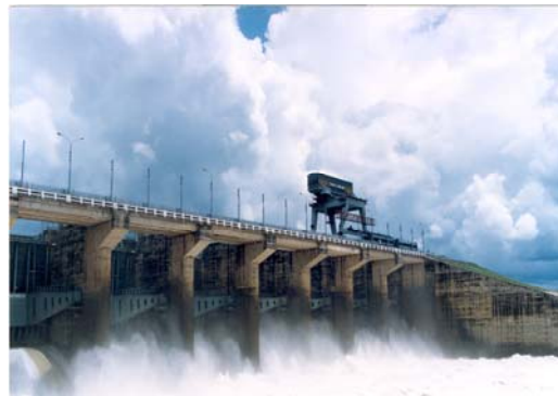
Nhà máy thủy điện Trị An 4x100MW – Công trình lớn đầu tiên ở Miền Nam Việt Nam
