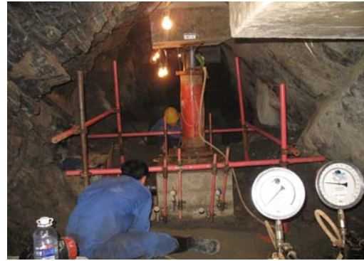
Thí nghiệm cơ địa trong hầm
