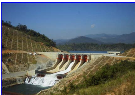
Đập tràn nhà máy thủy điện Hàm Thuận – Đami (475MW)
