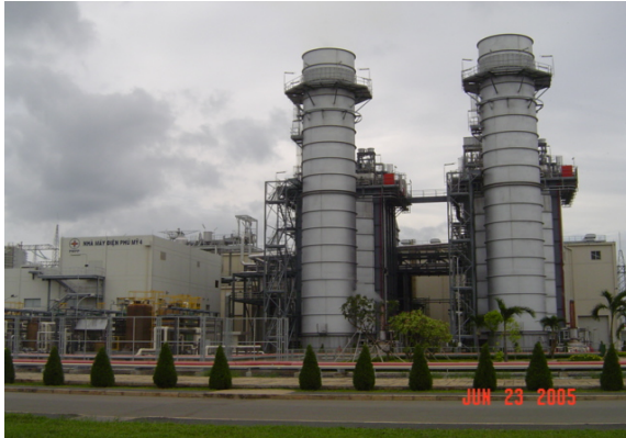
Nhà máy điện Phú Mỹ 4 – Công suất 450MW. PECC2 lần đầu tiên là tư vấn chính cho dự án TBKHH
