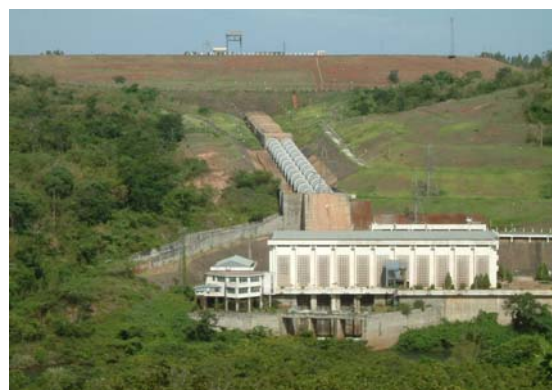
Nhà máy thủy điện Thác Mơ, 2x75MW
