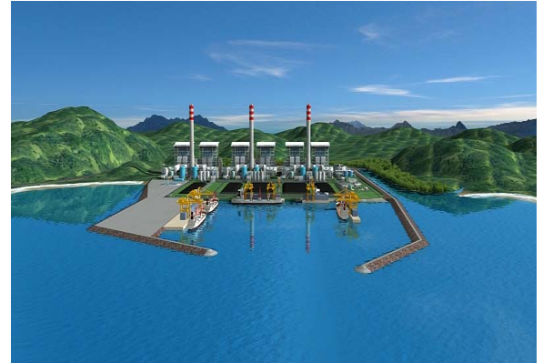
Trung tâm Điện lực Vĩnh Tân, quy mô 4 400 MW. PECC2 lập Quy hoạch & và làm tư vấn cho nhà máy điện Vĩnh Tân 1 và Vĩnh Tân 2.
