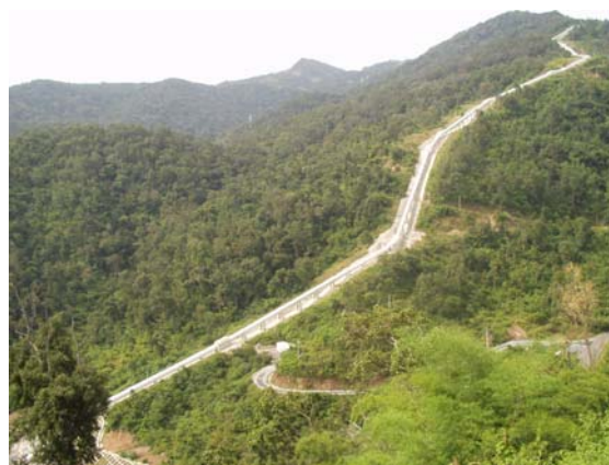
Nhà máy thủy điện Đại Ninh, 2x150MW
