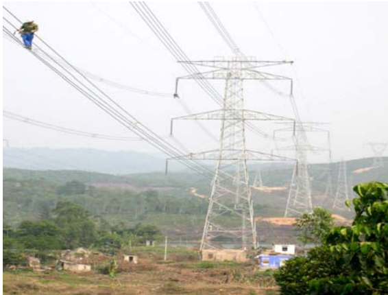
Đường dây 500kV Đà Nẵng – Hà Tĩnh
