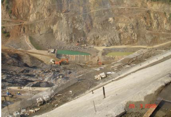
Nhà máy thủy điện Đồng Nai 4, 2x170MW, H=177m. Đập RCC cao thứ 4 của Việt Nam (Đang thi công hồ móng đập RCC)
