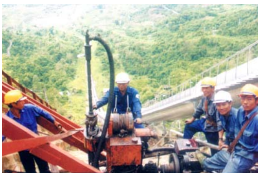
Khoan khảo sát công trình Thủy điện
