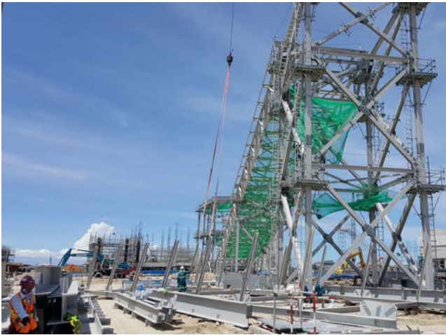
Kết cấu thép cho hệ thống CHS cho nhà máy nhiệt điện
