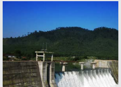
Đập tràn piano do TV2 thiết kế - thủy điện Đak Mi 4B
