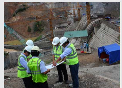
Trên công trường thủy điện Đồng Nai 5
