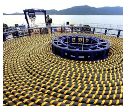
Bàn cáp nặng 4500 tấn tại dự án cáp ngầm 110kV Hà Tiên - Phú Quốc
