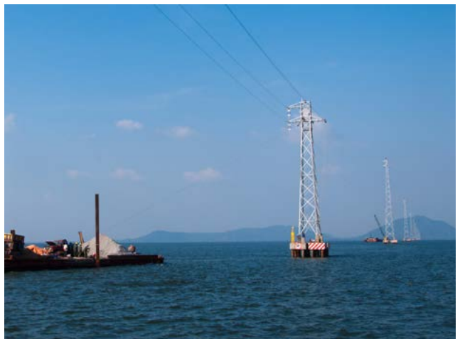
Cột điện thép mạ kẽm nhúng nóng đến cấp điện áp 500KV
