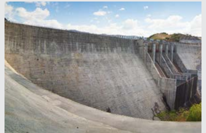
Đập thủy điện Đồng Nai 4
