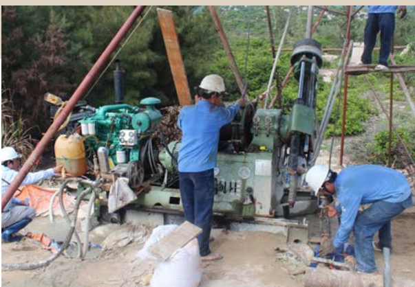
► Khoan nghiêng 45° tại dự án Điện hạt nhân Ninh Thuận 1
