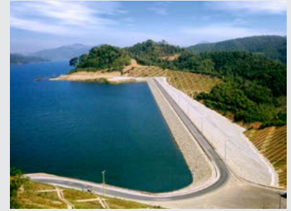
Nhà máy thủy điện Hàm Thuận (300MW)
