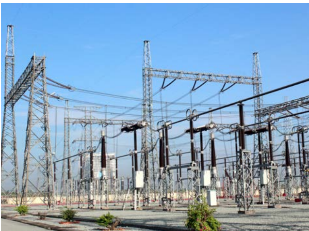
Giàn cột cổng & Giá đỡ thiết bị các loại cho các trạm biến áp đến 500KV
