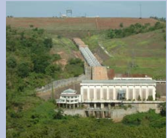
NMTĐ Thác Mơ (2x75 MW), H=90m. Lần đầu tiên TV2 làm Tư vấn Thiết kế chính
