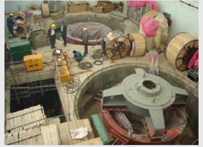
Giám sát thi công lắp đặt tại nhà máy Thủy điện Srêpok 3
