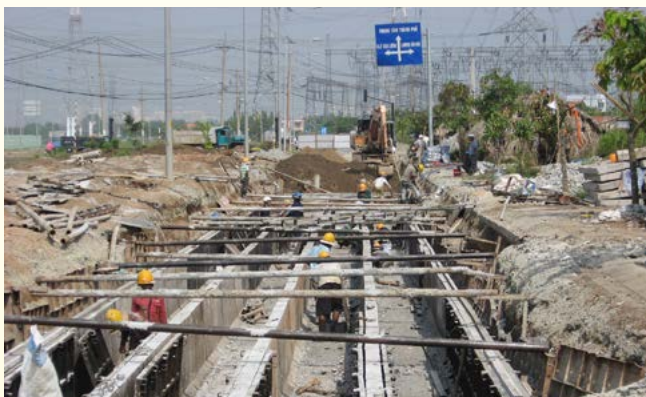
Tuyến cáp ngầm 220kV, dự án EPC di dời lưới điện qua khu Nhà Bè Metrocity
