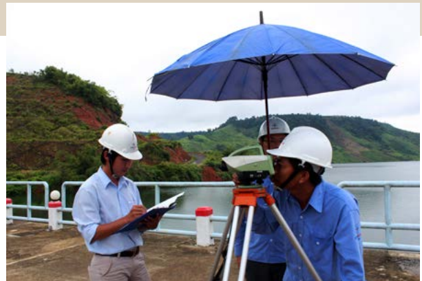
► Đo quan trắc biến dạng công trình thủy điện Đồng Nai 3
