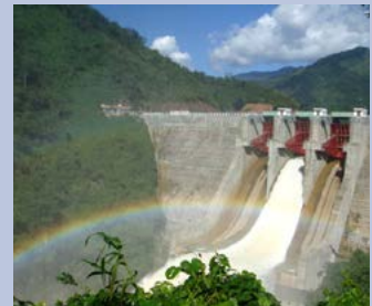
Đập RCC cao 80m đầu tiên của Việt Nam, công trình Thủy điện A Vương (2x105MW, H=300m)
